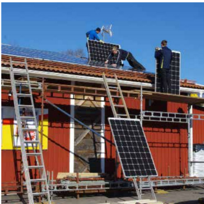
Monterina av solpaneler av duktiga montörer från SOLECT POWER
