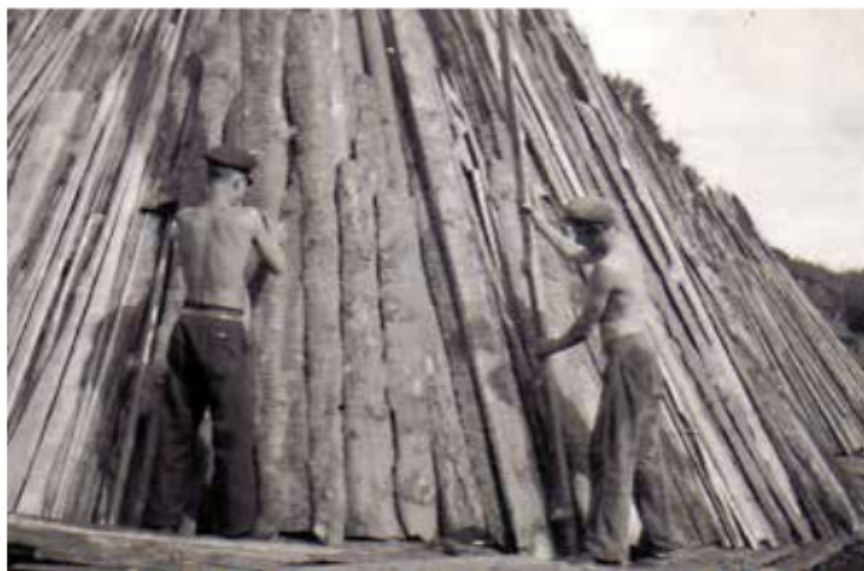
Att dra eller bära fram ribb och sätta upp till en 120 kubikmeters mila är inget söndagseftermiddagsjobb, det går väl åt så där en 9275 styck ribb och krakar, som ska staplas så tätt som möjligt för att undvika frät i milan.
