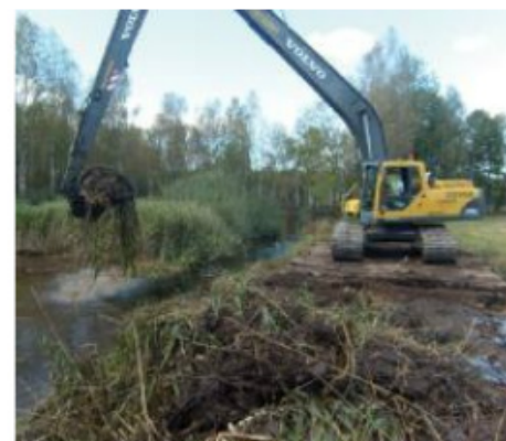
Med insatser av proffsiga entreprenörer genomfördes arbetet.
