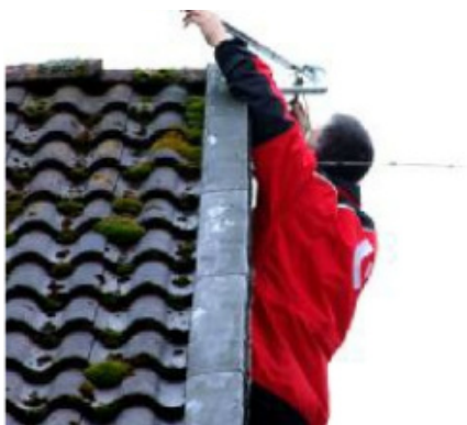
Jonas Nilsson, Relacom, monterar upp den nyframtagna antennen som riktas mot mobilmasten för säkra mot trafikavbrott.
