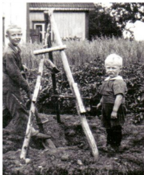
Nils-Erik och Torsten bryter sten med sin egengjorda stenkran
