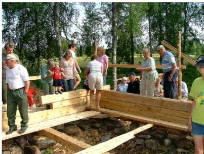
Åke Eriksson och Ingvar Johansson har satt dymlingarna på plats och är klara att banka ner dem genom två stockvarv, varefter de sågas av och bankas ner ytterligare cirka 5 cm.
