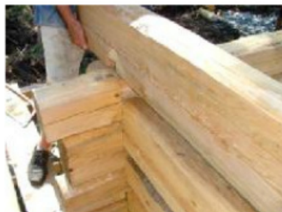
Anders Aronsson visar detalj ur arbetet med att hugga ut en hakknut med tröskel, även kallad enkel kattknut, vilken ska
