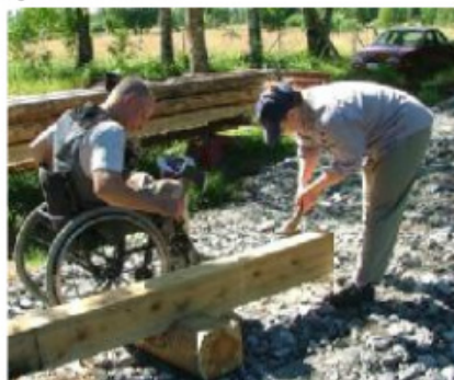
John Sollenberg och Desirée Nilsson använder bilen för att få den rätt finish på stocken yttersida.
