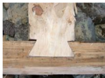
Mittbjälken, vilket golvplankorna ska vila på är inlaxad i bottensyllen.
