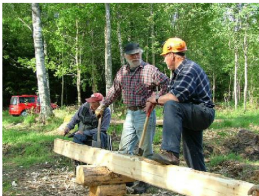
John Sollenberg, Åke Eriksson och Gunnar Karlsson arbetar med bandsåg och skräyxa på furustockarna, som är 6 tum tjocka 5,5 - 6 meter långa.
