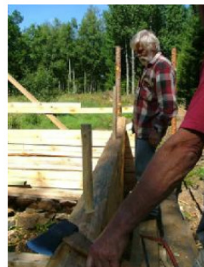
Åke Eriksson och Ingvar Johansson har satt dymlingarna på plats och är klara att banka ner dem genom två stockvarv, varefter de sågas av och bankas ner ytterligare cirka 5 cm.
