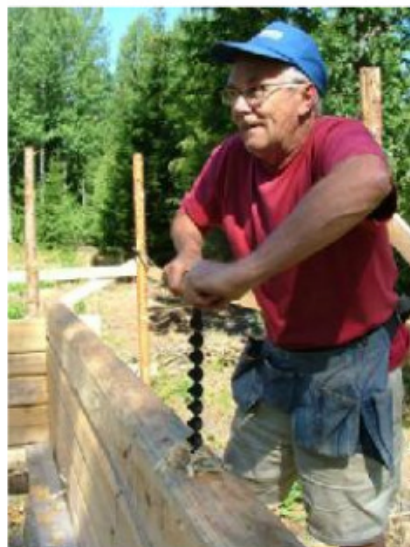
Ingvar Johansson borrar hål för dymlingar med navare, det behövs två kraftiga dymlingar i varje stock, varefter dymlingarna bankas ner i nästa stockvarv.
