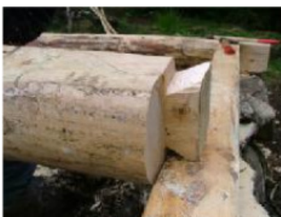
Mittbjälken, vilket golvplankorna ska vila på är inlaxad i bottensyllen.
