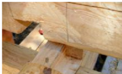
Mittbjälken, vilket golvplankorna ska vila på är inlaxad i bottensyllen.
