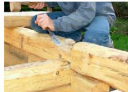
inpassas in i underliggande bjälke. Stefan Nilsson justerar hakknuten med stämjärn och träklubba.
