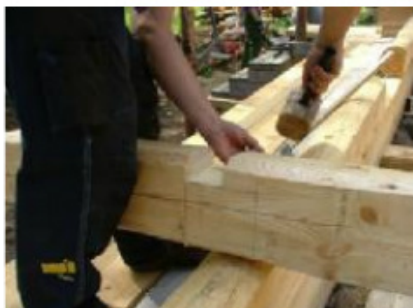
Anders Aronsson visar detalj ur arbetet med att hugga ut en hakknut med tröskel, även kallad enkel kattknut, vilken ska
