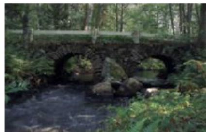
Valvbron vid Tjurkö 2003 sedd från kvamsidan.
