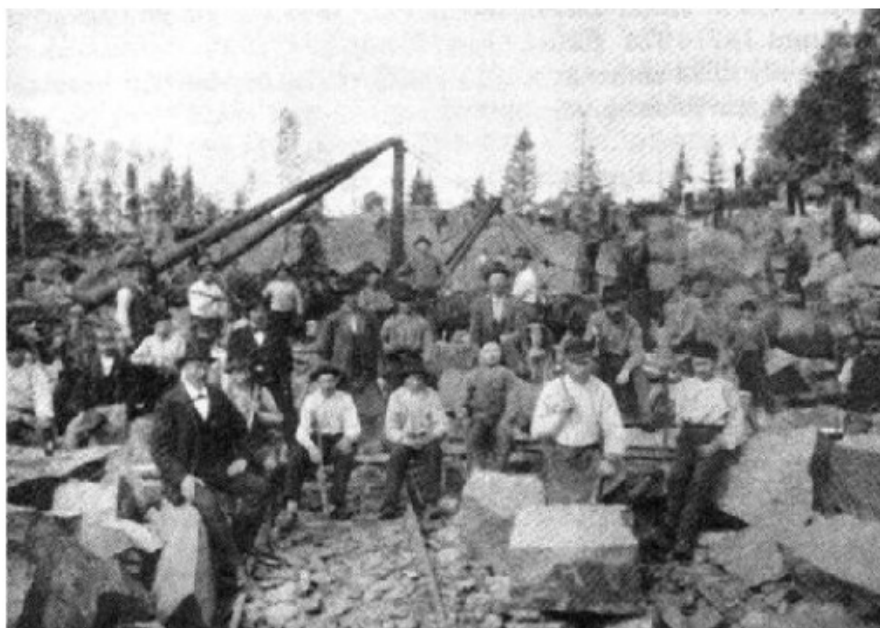
Arbete på gång i bergsbrottet
