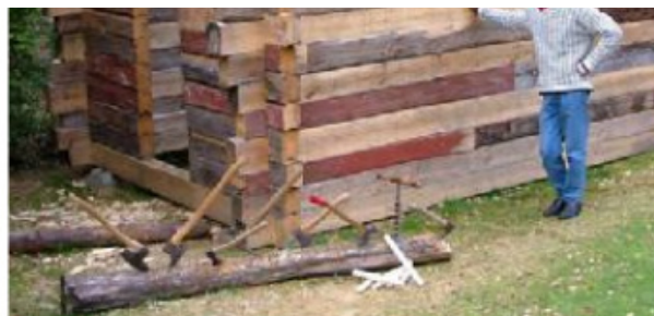
Stefan Nilsson vid sin knuttimrade byggnad
